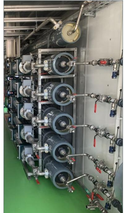
Blick in den Container auf die halbdurchlässigen Membranen der RO-Anlage
